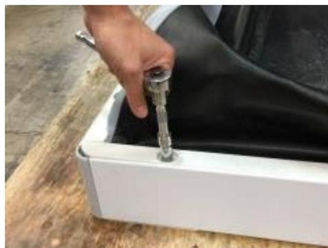
5. Les barres latérales ont une fente sur l'extrémité avant et la fente s'adapte sous la barre adjacente. Desserrez la fixation sur la barre adjacente, puis soulevez la barre latérale.
